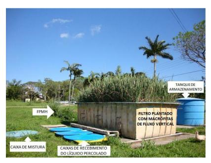
**Figura 1**. Fotografia do sistema de tratamento de lodo de tanque séptico. Fonte: arquivo pessoal.
