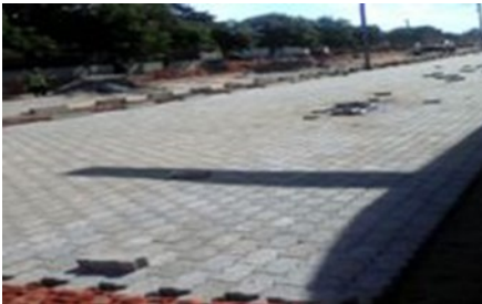
Figura 4 - Pavimentação da rua onde funcionava antiga pista de aterragem de aviões
