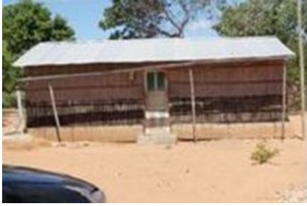
Figura 2 - Habitações de material convencional; casa típica de caniço, estacas e capim, estilo mantido pela cultura local.
